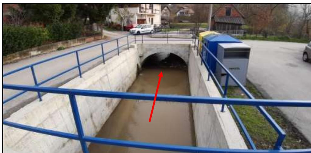
**Slika 2.1-4.** Regulacija korita i pokosa betonskim dnom i okomitim betonskim zidovima te cestovni propust u stac. km 11+190,00, s označenim smjerom tečenja (izvor: Viacon, 2019.)
