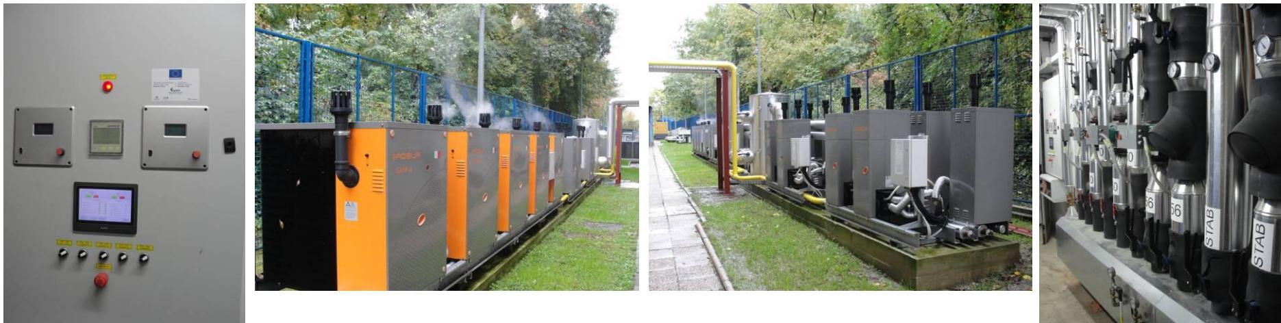
U okviru projekta provedena je zamjena opskrbe toplinskom energijom sustavom toplovoda iz vanjskog opskrbnog sustava s vlastitim postrojenjem za proizvodnju topline na bazi prirodnog plina kao goriva, te u kombinaciji s korištenjem toplinske pumpe i kondenzacijskog bojlera.
