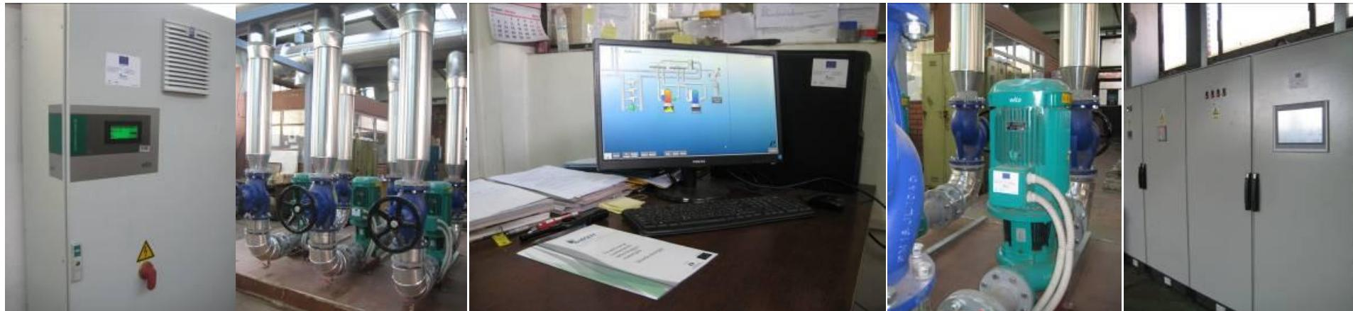
U okviru projekta provedeno je više tehničkih zahvata i mjera: umjesto lož ulja kao novi energet koristi se prirodni plin; provedena je rekonstrukcija kotlovnice, a 5 starih kotlova na lož ulje zamijenjeno je s 4 nova kondenzacijska kotla; također je uveden i sustav automatskog praćenja i nadzora tlaka vode te niz drugih povezanih mjera.
