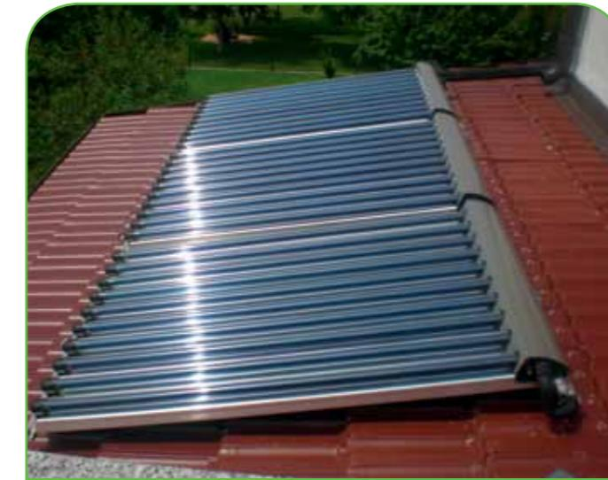
Slika 2.6. Vakuumski solarni kolektor
