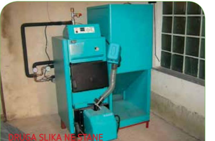
Slika 2.20 Kotlovi na pelete sa spremnikom za gorivo i automatskom regulacijom punjenja
