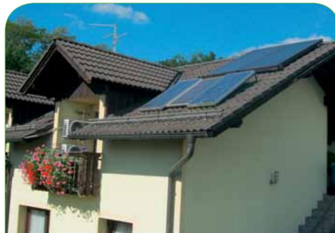
Slika 2.9 Fotonaponski paneli i kolektori za pripremu tople vode
