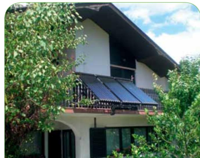
Slika 2.4 Solarni kolektori za pripremu tople vode
