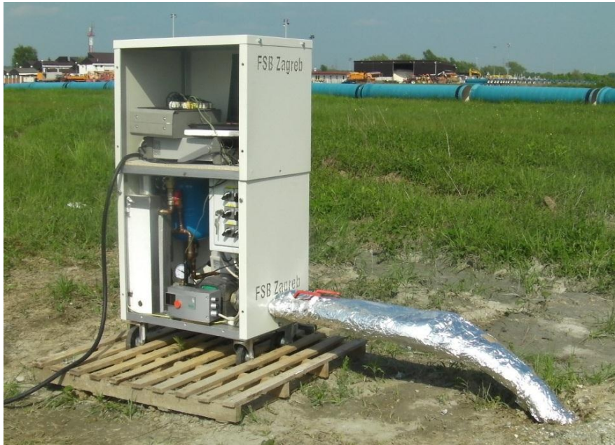
TRT test na lokaciji IKEA Rugvica
