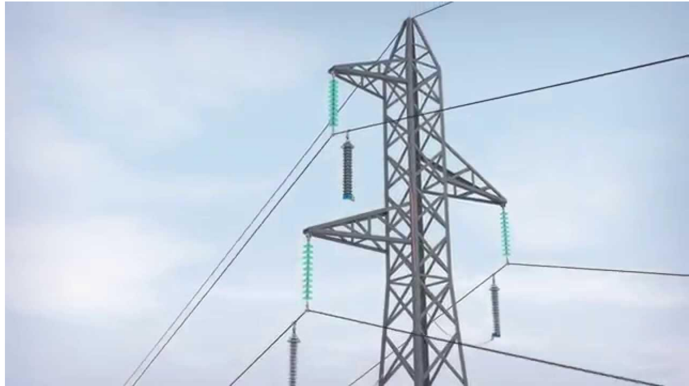
Odvodnici prenapona na dalekovodnom stupu
